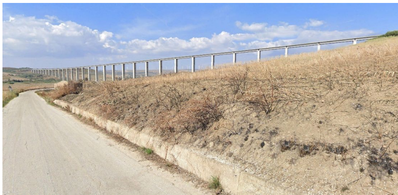
Figura 3 11 - Stato attuale Viadotto Carboj
