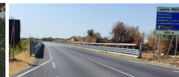
Figura 3-5- Barriere di sicurezza
